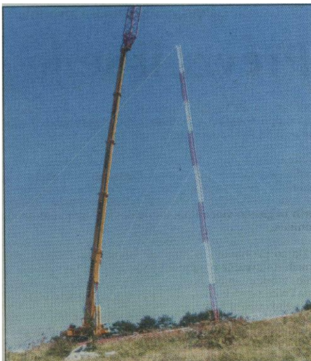
Stometsrska merilna antena na Volovji rebri, ena izmed številnih, ki merijo veter
